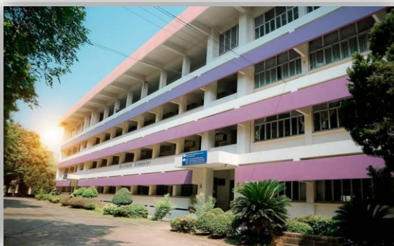
อาคารสุทโธนาคราช ลักษณะอาคารคอนกรีต 4 ชั้น 2,400 ตร.ม. ก่อสร้าง พ.ศ.2541 วงเงิน 12,930,000 บาท (งปม.)
