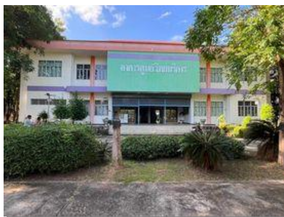
อาคารศูนย์วิทยบริการ ลักษณะอาคารคอนกรีต 2 ชั้น 1,500 ตร.ม. ก่อสร้าง พ.ศ. 2547 วงเงิน 8,090,000 บาท (งปม.)
