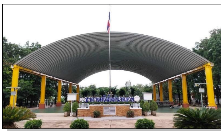
อาคารศรีสัตตนาคราช ลักษณะอาคารเป็นหลังคาคลุมลานเอนกประสงค์ ก่อสร้างปีงบประมาณ พ.ศ.2566 วงเงิน 6,450,000 บาท (งปม.)
