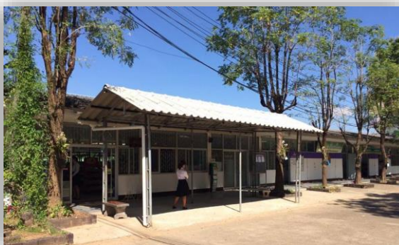
อาคารปัพพาลนาคราช ลักษณะอาคารคอนกรีต 1 ชั้น 512 ตร.ม. ก่อสร้าง พ.ศ.2540 วงเงิน 700,000 บาท (งปม.)
