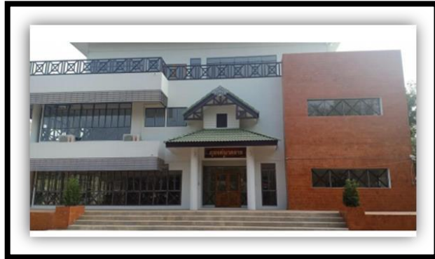
อาคารภูงศ์นคราษ ลักษณะอาคารคอนกรีต 4 ชั้น 1,088 ตร.ม. ก่อสร้าง พ.ศ.2562 ใช้งานได้ดี วงเงิน 11,450,000 บาท (งปม.)
