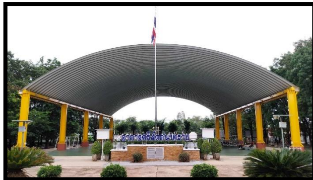
อาคารศรีสัตนาคราษ ลักษณะอาคารเป็นหลังคาคลุมลานเอนกประสงค์ ก่อสร้างปีงบประมาณ พ.ศ.2566 วงเงิน 6,450,000 บาท (งปม.)
