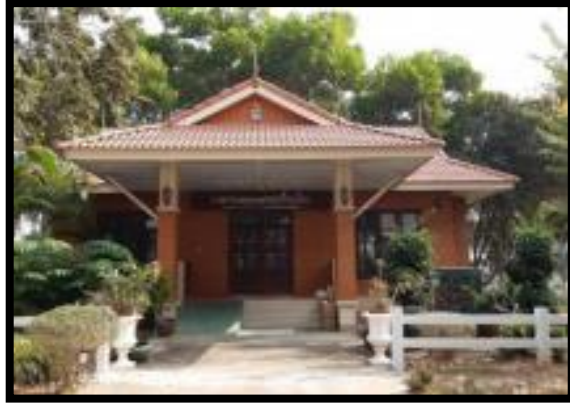
อาคารพฤษศาสตร์ ลักษณะอาคารไม้ 1 ชั้น
